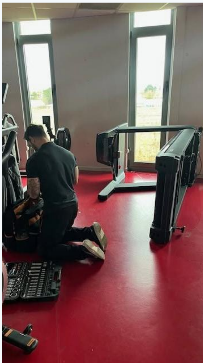
Intervention sur le parc fitness.
